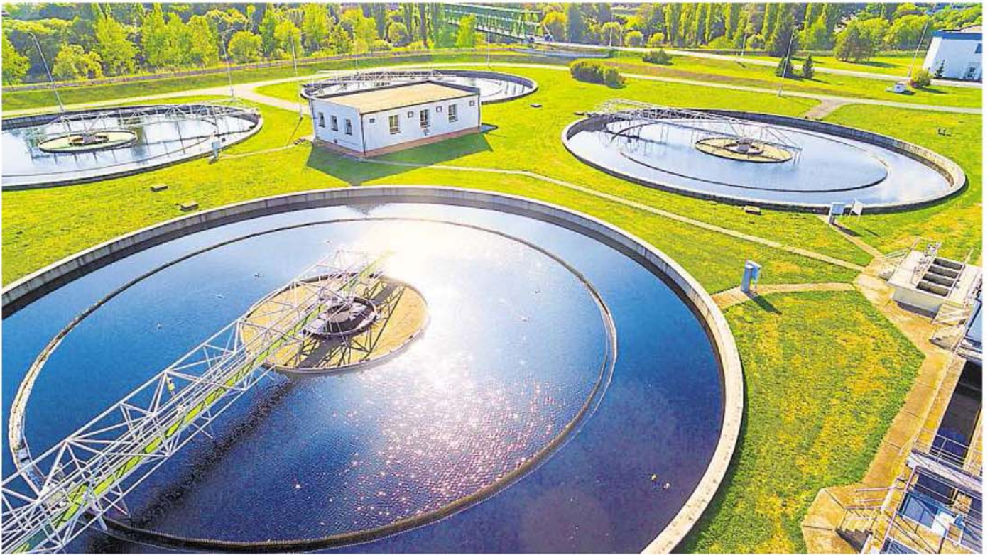
Die Schwelle für Direktvergaben von öffentlicher Hand, etwa für Kläranlagen, soll erhöht werden, damit Aufträge schneller in den Planungsbüros ankommen, fordert Horst Lenz, Präsident der Ingenieurkammer Rheinland-Pfalz. Archivfoto: Klettr, stock.adobe
