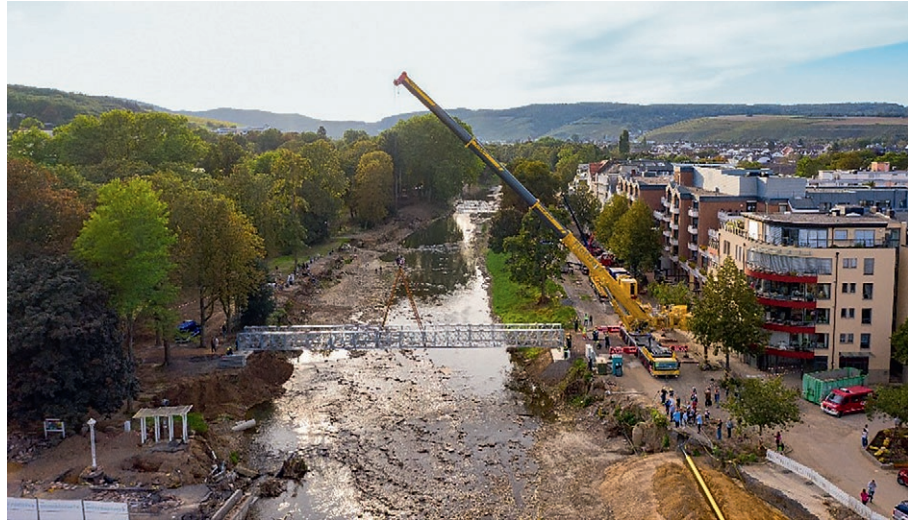
Insgesamt fünf Behelfsbrücken hat die Planung GmbH für die Stadt Bad Neuenahr-Ahrweiler über die Ahr projektiert - drei weitere sind in Planung.
